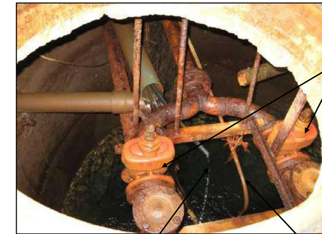
Rejet de l'eau du turbidimètre
