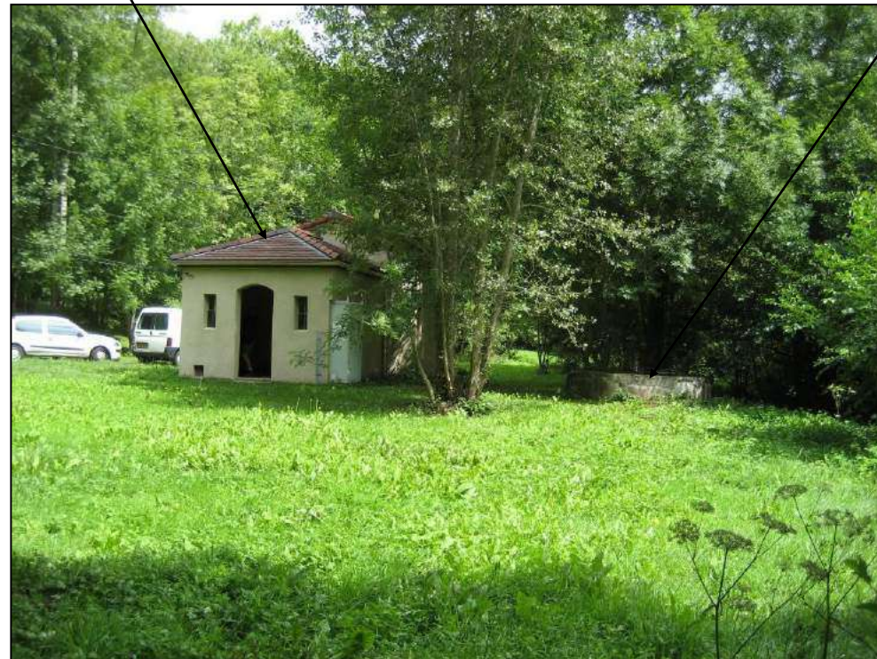
Local de traitement
