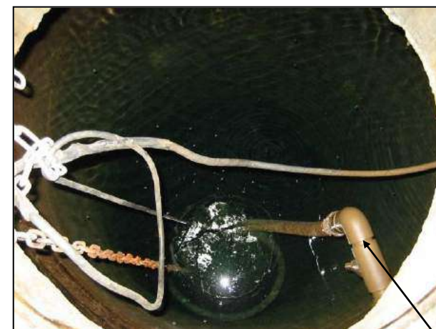
Vue intérieur du second puits de renforcement
