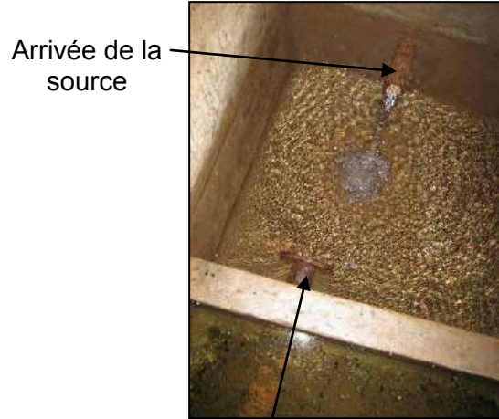
Départ de la conduite d'adduction non crépiné
