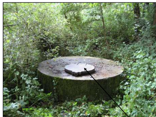
Capot recouvrant ne fermant pas à clé (système de clé triangulaire)
